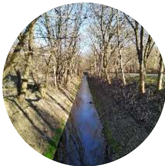
Zpevněné břehy potoka u Pálkařské ulice
